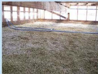
■『ポラスα ® 』を敷設した脱臭層
