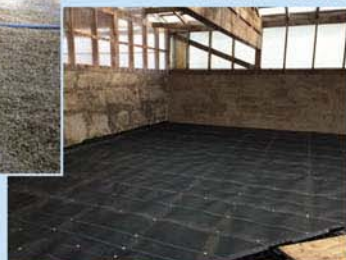
■ 敷設前の脱臭層
